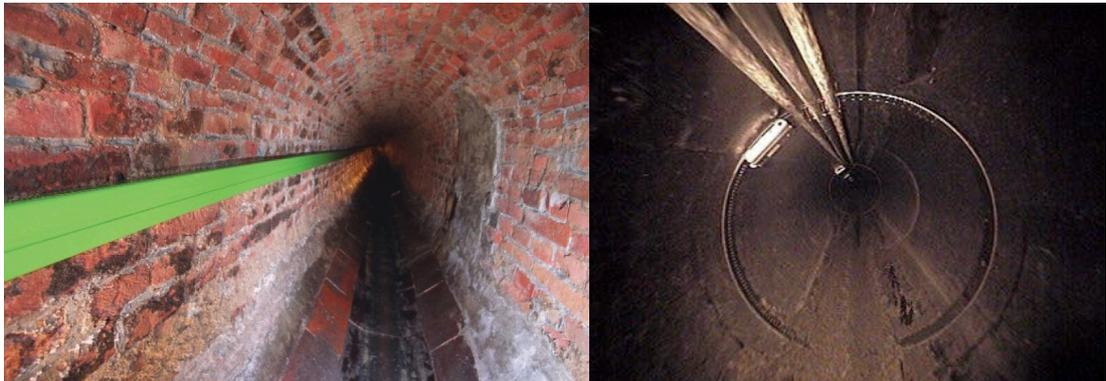
Abbildung 39: LWL-Verlegung im Abwasserkanal (metallfrei und metallisch)
