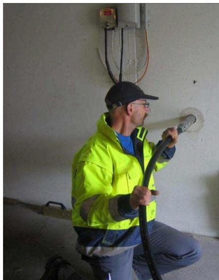
Abbildung 41: Ansetzen einer Erdrakete im Keller
