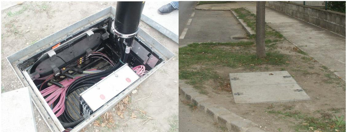
Abbildung 44: Straßenschacht bestückt für 72 Mikrorohre mit Betondeckel
